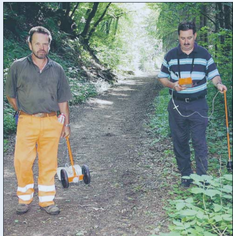
Gerd Seegmüller von den Werken (links) und Armin Petry von der Firma Raesch messen nahe der Kläranlage, wo das Gas austritt, das sie vorher in die Trinkwasserleitung gepumpt haben. —FOTO: MOSCHEL
